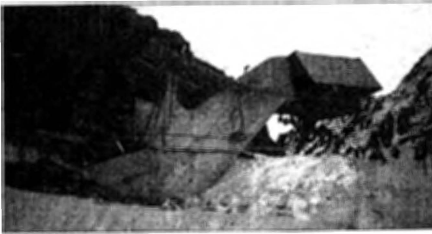
Abb. 17. Doppelsesselbahn Daunferner I (Stubai Gletscher-Schigebiet). Horizontal im Quarzitzgneis über die Randklufft aus- kragend geankerte Talstation.
