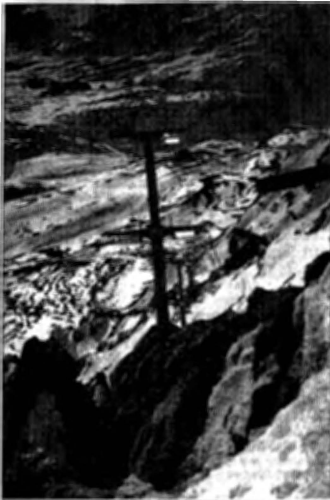
Abb. 14. Doppelsesselbahn Schindlergrat St. Anton a. A. Ansicht der verankerten Stützen in den Arlbergschichten der Südostwand.
