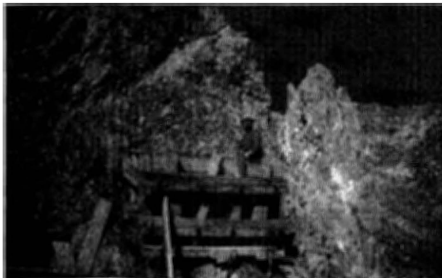
Abb. 20. Lawinensprengseilbahn Kaminspitzen (Nordkette Innsbruck). Horizontal verankertes Stützenfundament im Bauzustand.
