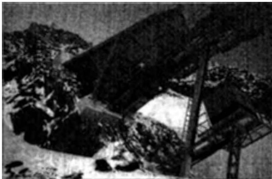
Abb. 19. Gletscherschlepplift Daunferner II (Stubai Gletscher-Schigebiet). Horizontal verankerte Bergstation mit Antrieb, Ab- spannung und Trafo.
